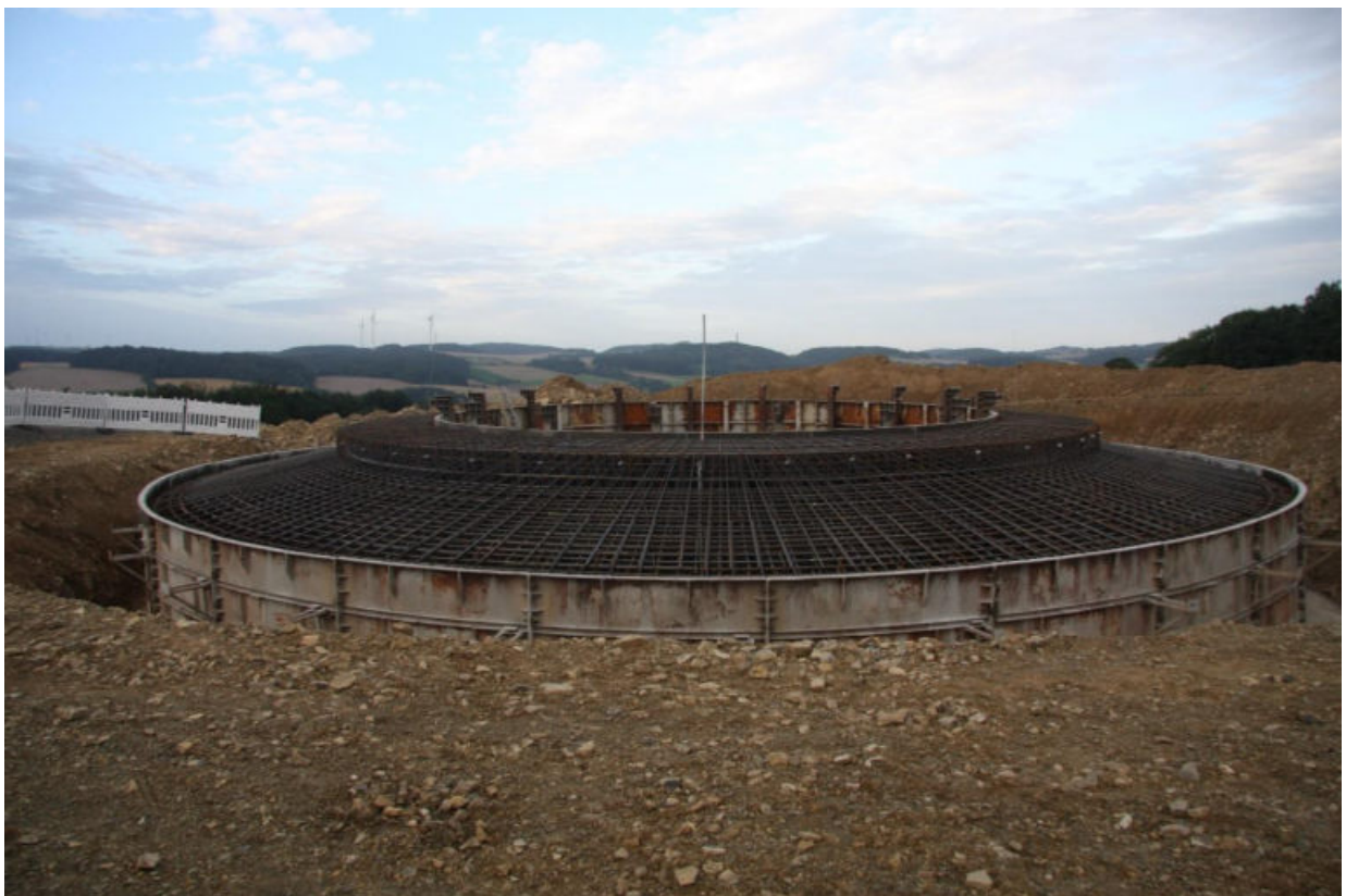
Abb. 3: Verschalung und Bewehrung des Flachfundamentes einer Windenergieanlage (BGU, 2016)
